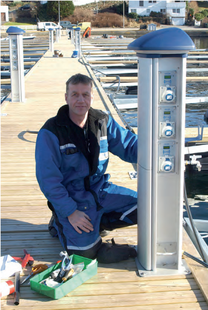
Rune Gundersen fra Stavanger Innstallasjon
